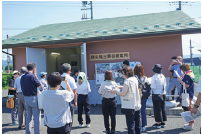
待矢場三栗谷発電所（小水力発電）
